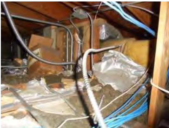
0002036e 4/24/2018 Conduit Attic
