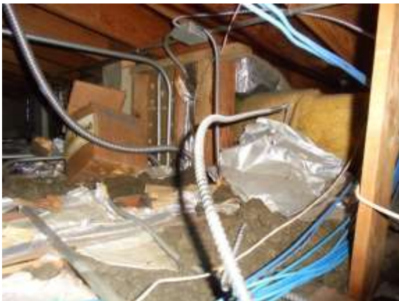
0002036e 4/24/2018 Conduit Attic
